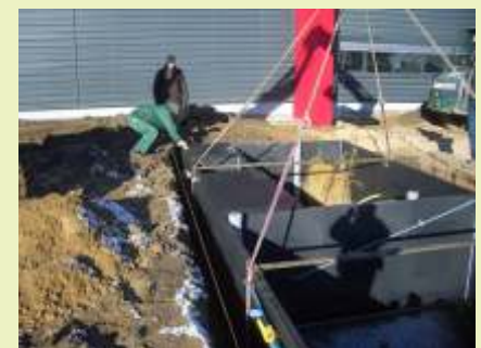
Hier entsteht ein 400 m 2 großer Zierteich auf dem Gelände einer Großdruckerei. Eine AQUANT-idbs 3-Anlage soll für klares Wasser sorgen.
