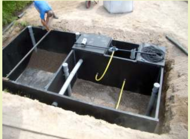
Zeitaufwand für den Einbau der Reinigungsanlage inklusive Anschlüsse Richtung Teich: 1 Tag.
