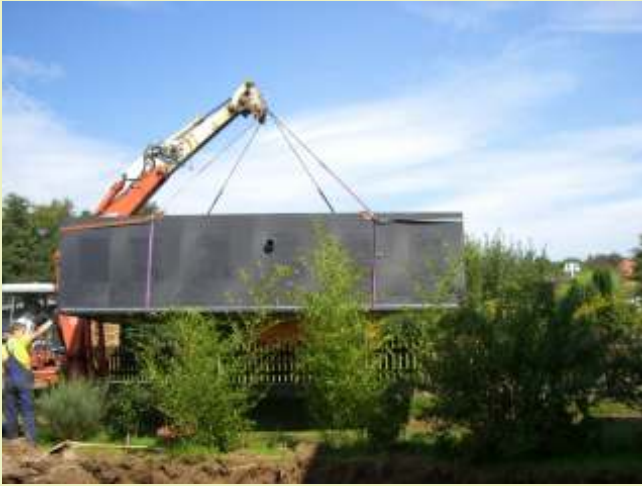
Eine AQUANT-idbs 2-Anlage wird zur Baugrube transportiert.
