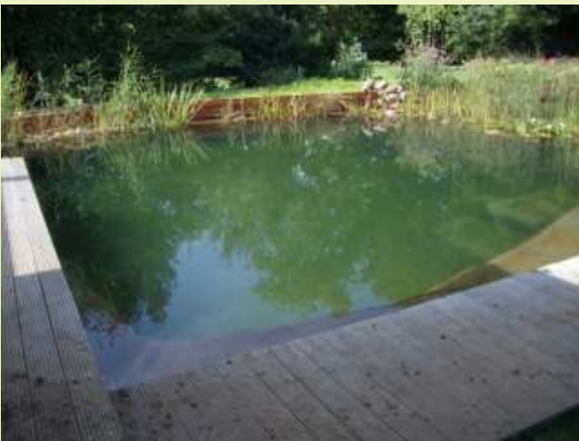
Der Schwimmteich funktioniert nicht, das Wasser ist grün und trüb.
